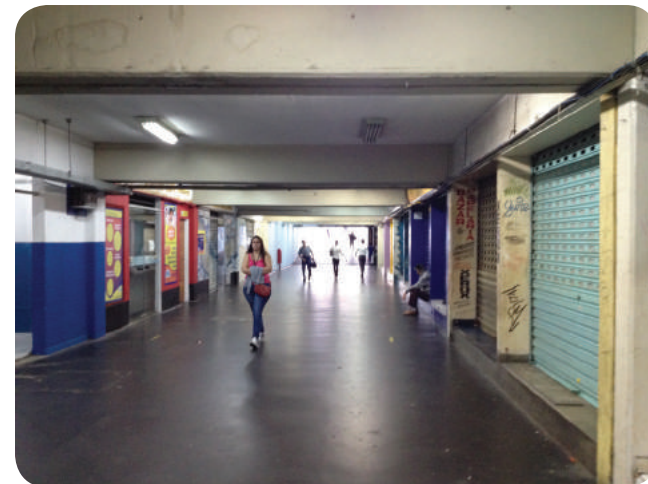
Foto 8: Passagem subterrânea sob a linha férrea, o local registra intensa circulação de pedestres durante todo o dia. Fonte: Do autor
